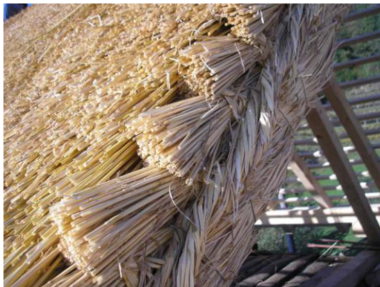
Le redki stari mojstri še izdelujejo slamnate strehe pri nas. Na sliki Zvonko iz Frankolovega pokriva streho obnovljene hiše v Zavrchu pri Galiciji.
