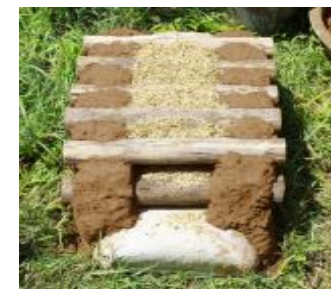
Zgoraj: gradnja zidov iz cordwooda. Med dvema plastema veziva vidimo toplotno izolacijo, v tem primeru žagovino. Levo: bodoči mojster s svojo prvo steno.
