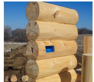
Slika 1 - Primer vogalne vezi pravokotnih brun. Slika 2 - Način stikovanja okroglih brun v steni brunarice.
