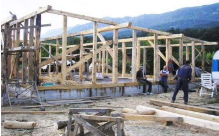
Primer lesene skeletne gradnje pri Ajdovščini. Med leseno konstrukcijo se naknadno vstavi slamnate bale.
