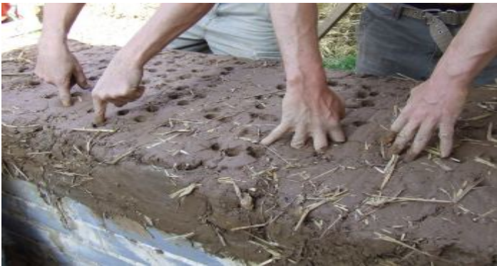
Ročna gradnja zidu: na sliki gradnja brez opaža. Zmes gline, peska, slame in vode se preprosto nalaga in s tem gradi zid. S prsti ali palicami nato luknjamo zid, da se plasti ilovice ter slamnate bilke, ki delujejo kot armatura, med seboj bolje povežejo.
