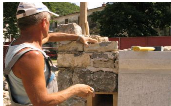
Gradnja kamnitega zidu.
