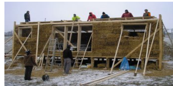
Nedelja zjutraj Gradnja prve samonosne slamnate hiše pri nas, v Metavi pri Mariboru. Gradnja prikazana od zgornje do spodnje fotografije je trajala samo deset ur.
