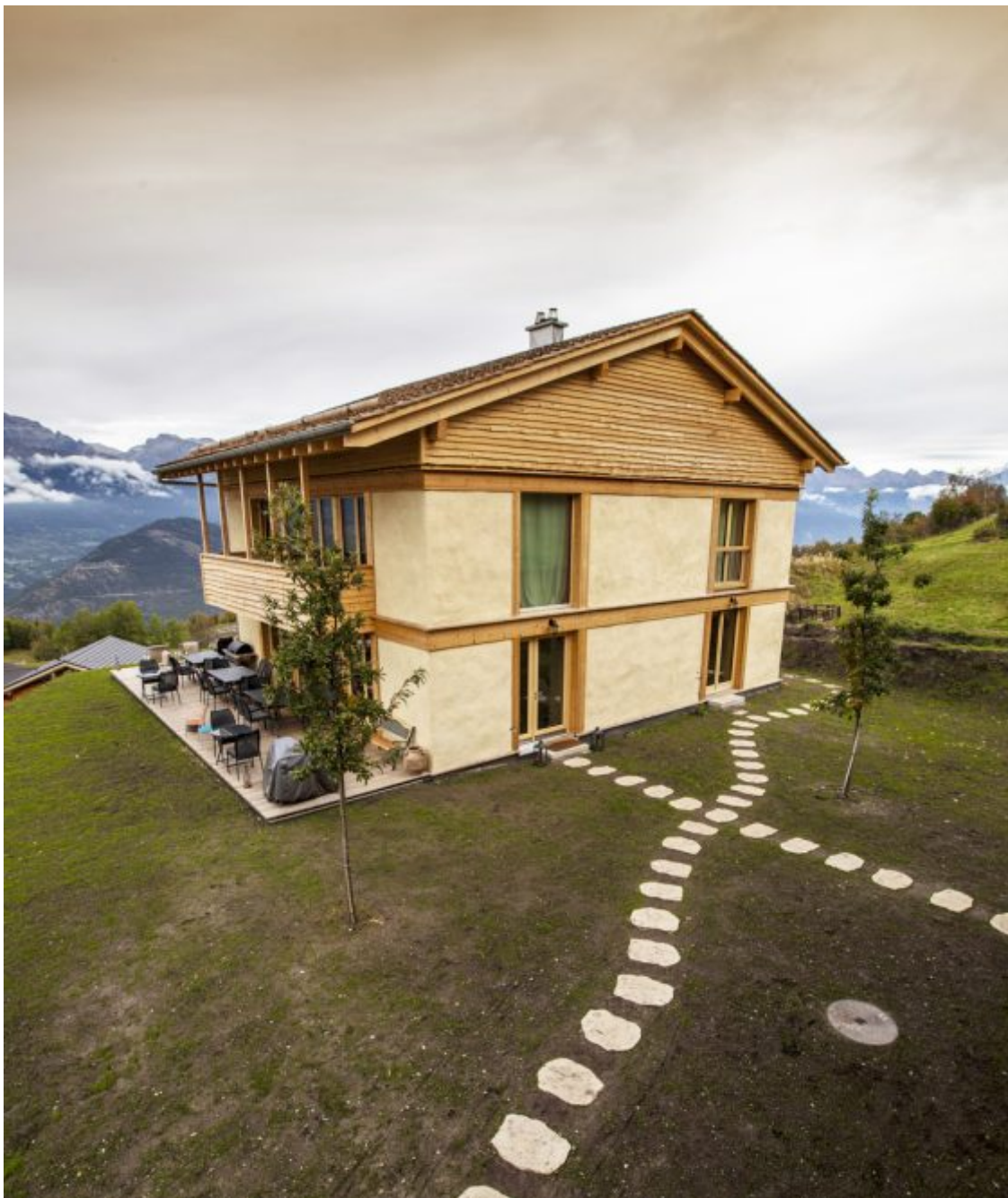
Naslovnica in slika zgoraj: Nastanitveni objekt Maya Guesthouse v Švici. Objekt je narejen po metodi lesene nosilne konstrukcije in slamnatih bal, ki so v tem primeru širine kar 1,2m. Objekt spada med t.i. superizolirane stavbe. Zunanji in notranji ometi so ilovnati, kritina pa je iz lesenih klanih skodel. Hotel je odprl svoja vrata leta 2012 in je prvi primer hotela, izoliranega v celoti iz slamnatih bal v Evropi. Avtor objekta je arhitekt Werner Schmidt.
