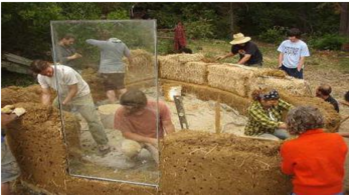
Ročna gradnja zidu: na sliki gradnja brez opaža. Zmes gline, peska, slame in vode se preprosto nalaga in s tem gradi zid. S prsti ali palicami nato luknjamo zid, da se plasti ilovice ter slamnate bilke, ki delujejo kot armatura, med seboj bolje povežejo.
