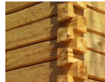
Slika 1 - Primer vogalne vezi pravokotnih brun. Slika 2 - Način stikovanja okroglih brun v steni brunarice.
