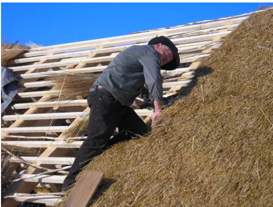
Le redki stari mojstri še izdelujejo slamnate strehe pri nas. Na sliki Zvonko iz Frankolovega pokriva streho obnovljene hiše v Zavrchu pri Galiciji.
