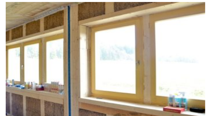
Primer gradnje s slamnatimi balami, ko se posamezne panele naredi že v delavnici in se jih na gradbišču samo sestavi.
